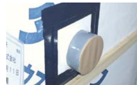
外壁貫通部の防水措置
