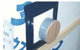
外壁貫通部の防水措置
