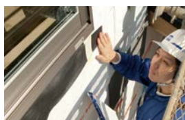
窓等の開口部の防水措置
