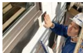
窓等の開口部の防水措置
