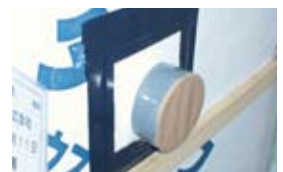
外壁貫通部の防水措置
